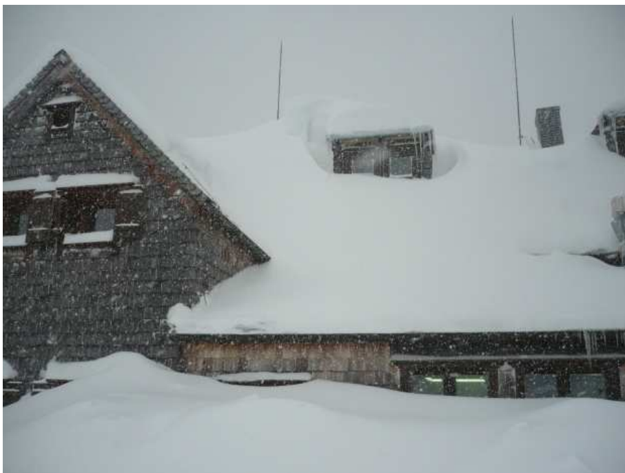
Detail na „uklizenou“ střechu. Před hodinou či dvěma tam Martin odházel všechen sních. Pro případné zájemce o návštěvu Erfurterhütte – uprostřed nevidíte okna pokojů 3, 5, 6, 7 a 8. ;)
